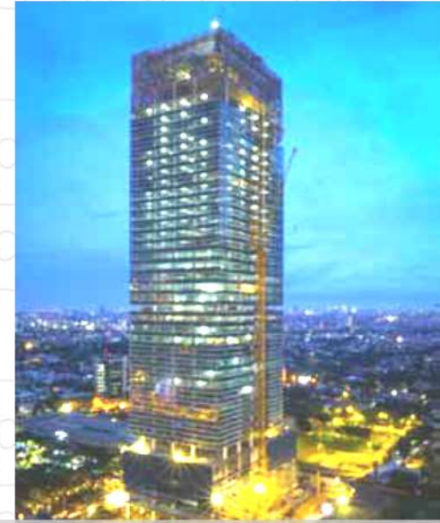
GRADE A OFFICE AT SCBD LOT. X JAKARTA KSO DENGAN PT TAKENAKA INDONESIA
