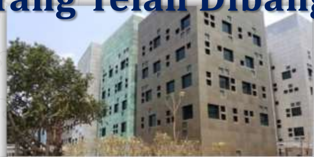
AUSTRALIAN EMBASSY, KUNINGAN - JAKARTA KSO dengan PT Leighton Construction Indonesia
