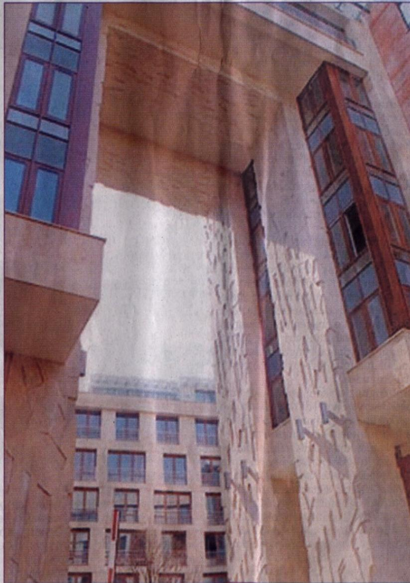
SISTEM KERING - Contoh bangunan berdinding granit yang dipasang dengan sistem kering.
