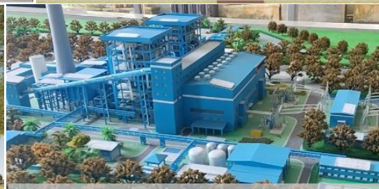
PLTU SUMBAGSEL - PALEMBANG
