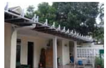
Perbaikan rumah warga
