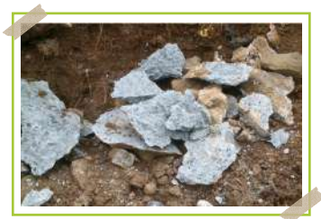
Hasil bobokan batu kali dibobok dengan ukuran besar dipecah dan dikumpulkan di daerah yang akan dipasang dinding penahan
